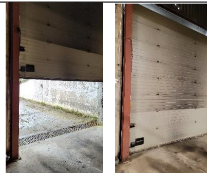
Bygg 1: Port mangler rømningsdør.
