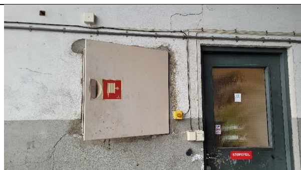
Bygg 1, 1.etg.: Brannslangeskap mangler plogskilt.
