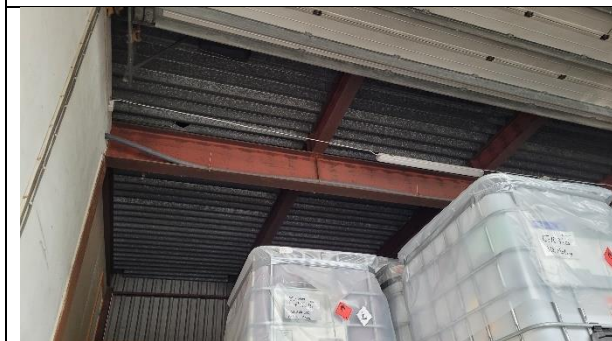
Lager i bygg 1 med betongvegger og stålbering i tak.
