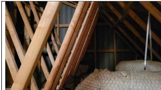
Bygg 1 og loft med grove trekonstruksjoner både i tak og dekke.
