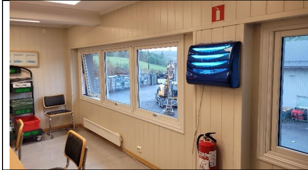
Bygg 1, 2.etg.: Vinduer som kan benyttes til rømning og har tilgang til rømningstrapp ned til det fri.
