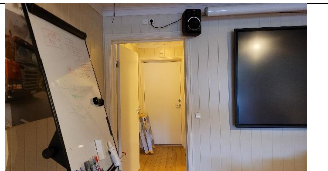
Bygg 1, 2.etg.: Utgang til internt trapp og dør til vestre, merkes med henvisningsskilt til utgang. I samme rom skal dør til lager ikke benyttes til rømning, da mottatte branntegninger viser utgang her.
