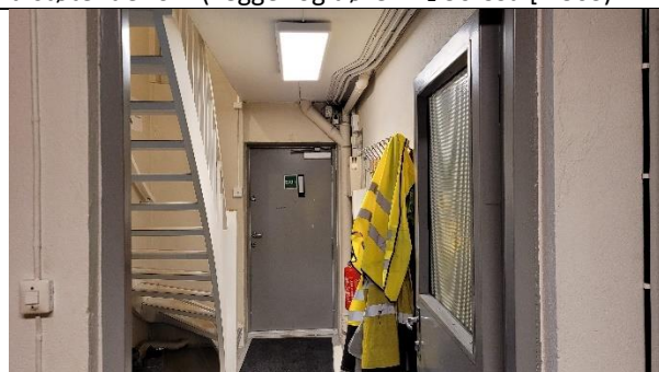
Bygg 1, 1.etg.: Dører til rømningsvei og garasje mangler tilstrekkelig brannklasse. Byttes til EI 2 60 CSa [B 60S].
