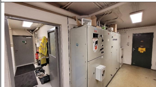
Bygg 1, 1.etg.: Dører til rømningsvei og garasje mangler tilstrekkelig brannklasse. Byttes til EI 2 60 CSa [B 60S].
