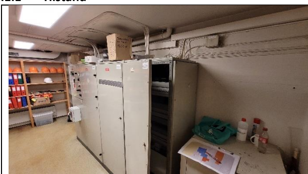
Bygg 3: Lagring i tekniske rom som tavlerom og ventilasjonsrom.
