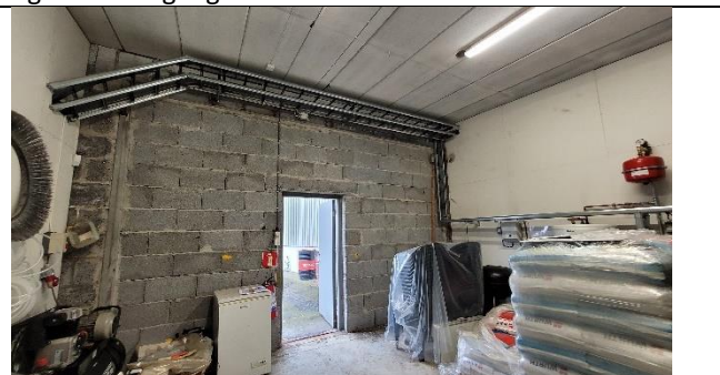
Bygg 1, 2.etg.: Utgang til internt trapp og dør til vestre, merkes med henvisningsskilt til utgang. I samme rom skal dør til lager ikke benyttes til rømning, da mottatte branntegninger viser utgang her.
